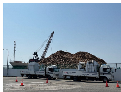
令和7年5月 石川県能登町 設置現場
